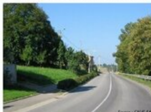
Création d'un trottoir et réduction de la largeur de la Chaussée à Sainte-Piile
