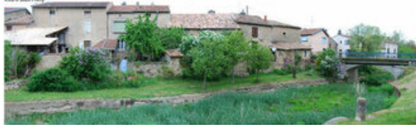
Les quais enherbés et plantés transforment le rivage en jardin au droit du village de Concheville
