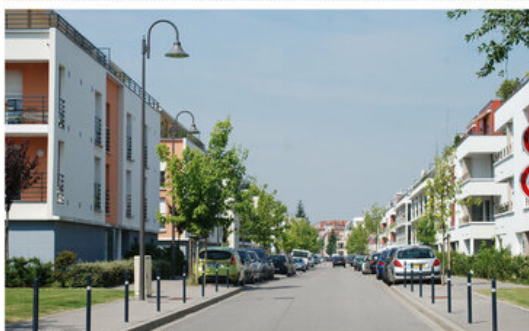
Des opérations de réhabilitation récentes en périphérie de Nancy
