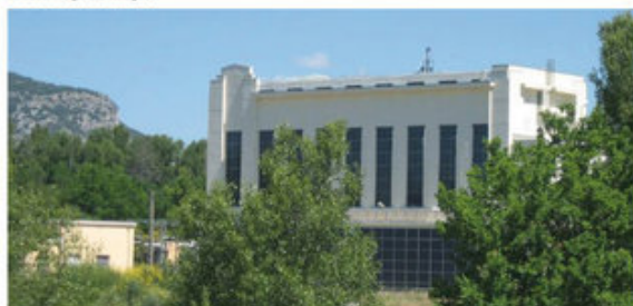
Panneaux solaires installés en façade : Bâtiment EDF le long du canal de La Durance.
