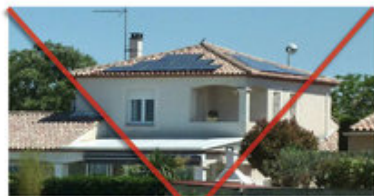
Panneaux rectangulaires apposés sur une structure toitures triangulaire.
