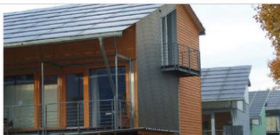
Panneau solaire faisant office de couverture "Toiture intégrée" dans la "Solariedlung" à Fribourg, Allemagne.
