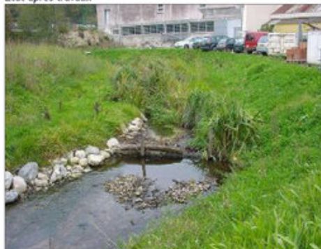
Etat après travaux
