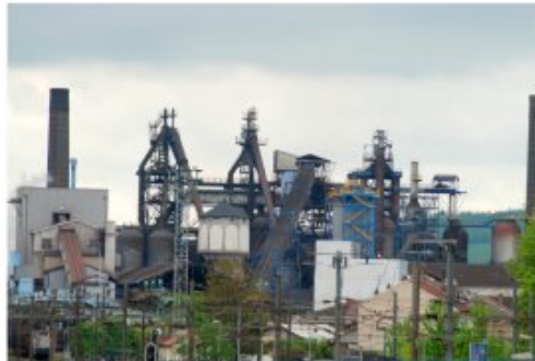
Le patrimoine industriel est un marqueur fort des paysages, principalement dans les vallées (Pont-à-Mousson)
