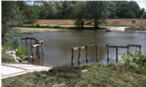
Appareillement du bac autotracé permettant à la piste cyclable de franchir l'Austrian sans ouvrage d'art
