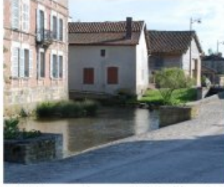
Bords de l'eau maçonnés ou non, bordés de végétation locale (Aube)
