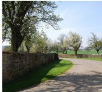
Clôtures de murets bas en pierre sèches ou maçonnés (Villers-le-Rand)
