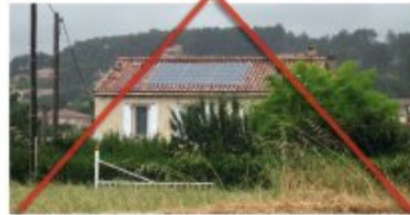
Installation de panneaux sans recherche de composition d'ensemble avec la toiture et le paysage.
