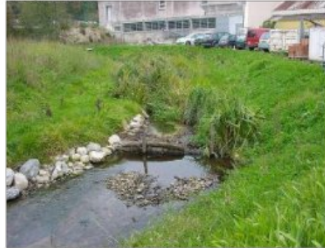
Etat après travaux
