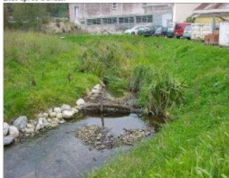
Etat après travaux
