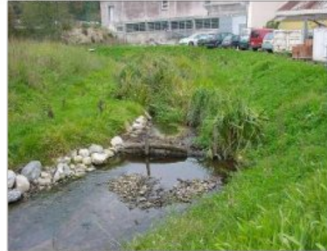
Etat après travaux
