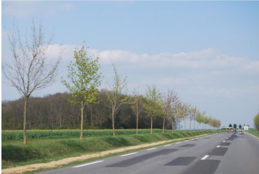
Cette replantation de la RD13H est judicieusement réalisée derrière un talus enherbé protecteur, ce qui évite l'utilisation de glissières standardisées.
