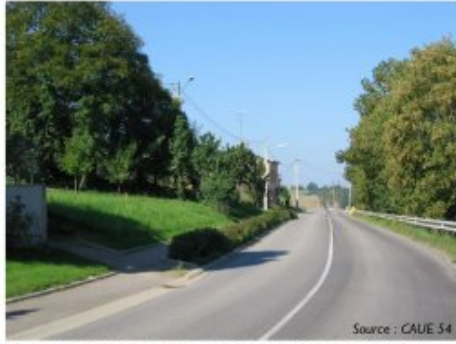
Création d'un trottoir et réduction de la largeur de la Chaussée à Sainte-Pôle
