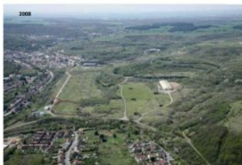
2008 Des études ont été menées afin d'identifier les espèces protégées et de prévoir les mesures permettant d'éviter, réduire et compenser les impacts du projet routier, des crapauds et des poissons à petite fosse sont notamment prévus.
