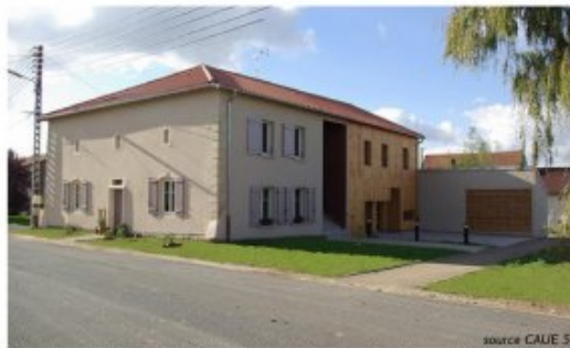
Extension contemporaine d'un bâtiment public dans le respect des volumes traditionnels, à Xarres
