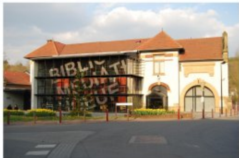
Un exemple intéressant de réhabilitation : les anciennes forges de Jœuf transformées en médiathèque
