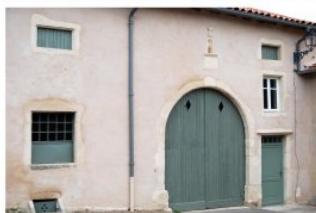
Revalorisation architecturale de ferme à Vlodromont. Enduit traditionnel à la chaux et saut apporté au choix de la couleur des huisseries
