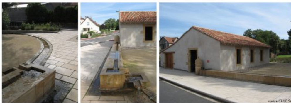
Exemple de mise en valeur du bâtiment et de la fontaine, avec un traitement d'espace public qualitatif et soigné, à Dancourt -Me-Corffans.
