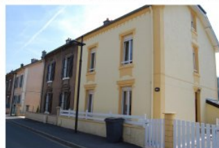
Un exemple de revalorisation de l'architecture des cités ouvrières par la couleur. Longwy
